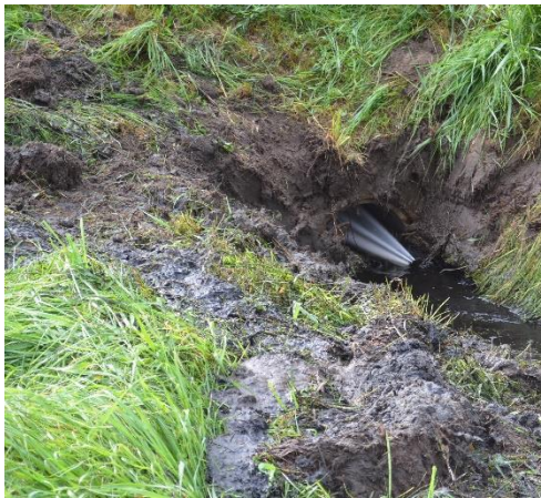
Einsatz Hochdruckspülgerät mit Räumdüse an einem Durchlass
