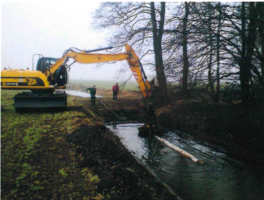
abflusssichernde Maßnahme, Freimachen eines verstopften Durchlasses
