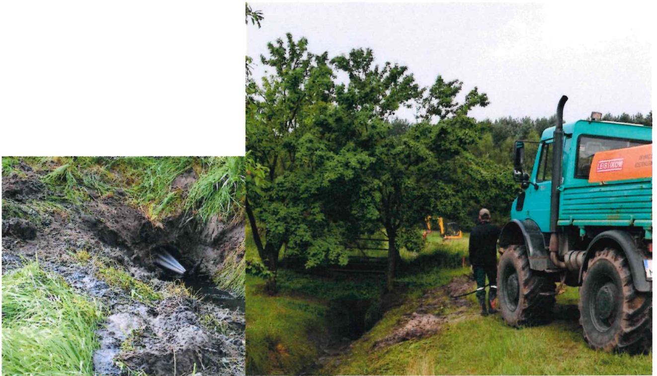
Einsatz Hochdruckspülgerät mit Räumdüse an einem Durchlass
