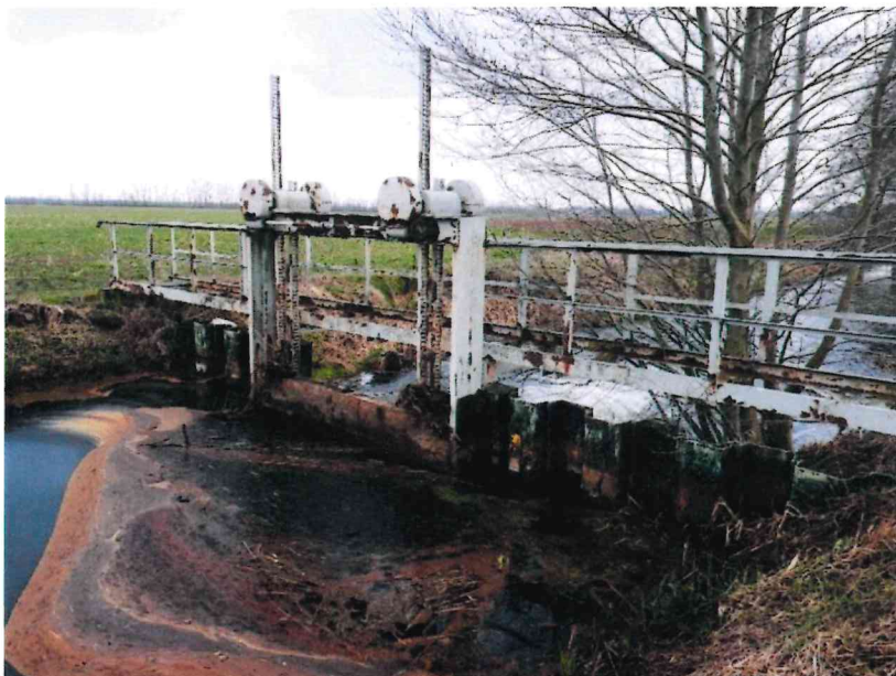
Mittlere Anlage vorher (eingeschränkt betriebsfähig)
