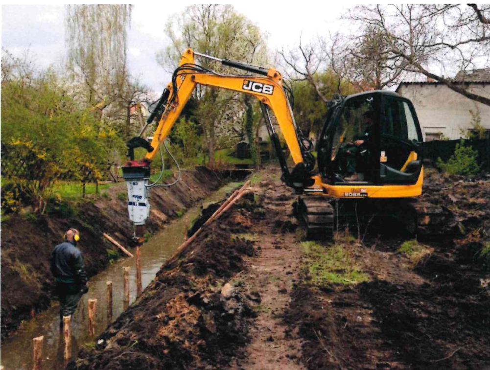
Einbau von Faschinen zur Böschungssicherung und Erhalt des Gewässerprofils
