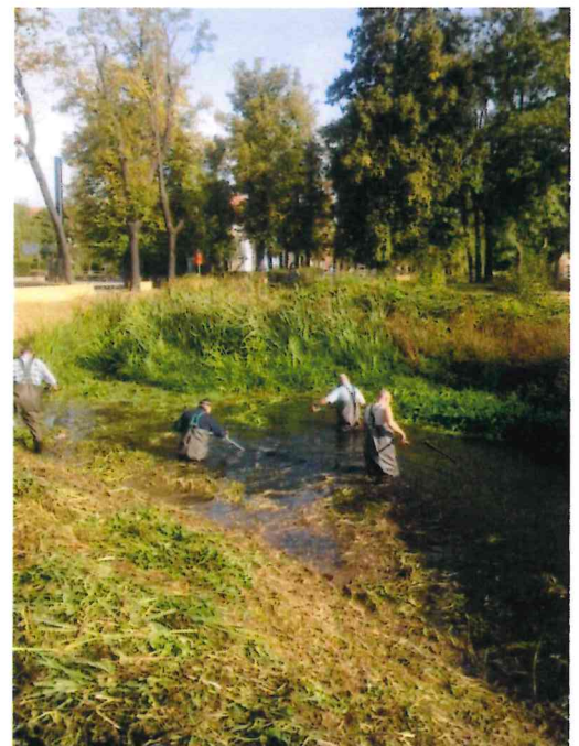
Sohlkrautung mittels Handarbeit
