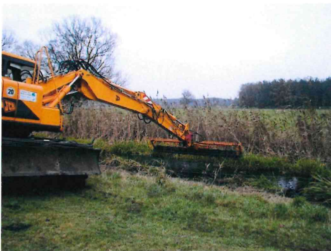
Sohlkrautung mittels Bagger mit Mähkorb
