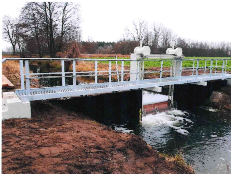
Mittlere Anlage danach (vollständig betriebsfähig)
